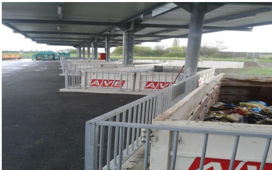
Εικόνα 43: Χώρος Διαλογής Ογκωδών Αποβλήτων
