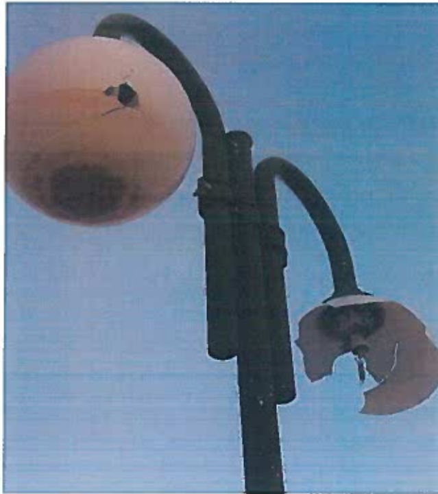
Εικόνα 8: Φωτιστικά πλατείας Κυδωνιάτη
