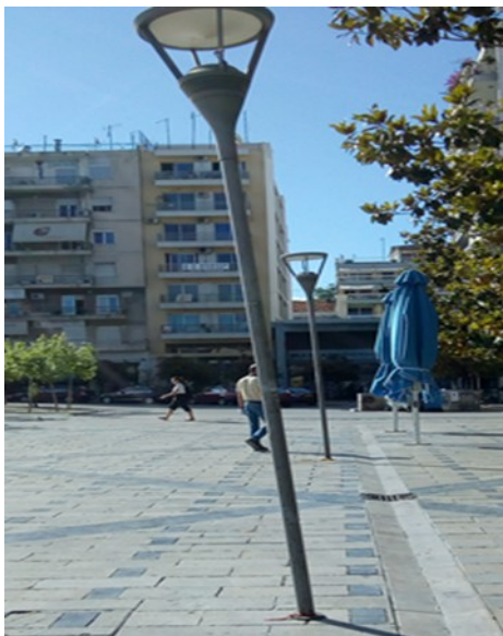
Εικόνα 11: Φωτιστικά στα οποία θα γίνει αντικατάσταση του ιστού.
