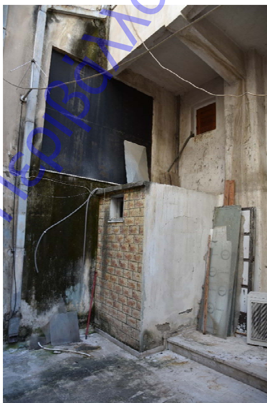
ΦΩΤ. 18: Προσθήκη χώρου υγιεινής στον ακάλυπτο του οικοπέδου
