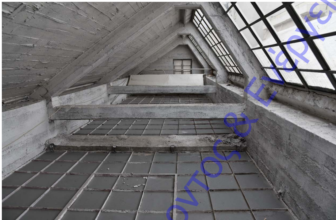
ΦΩΤ. 19: Φεγγίτες Αναγνώστηριου
