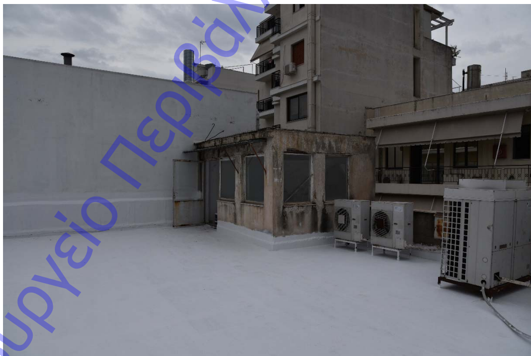
ΦΩΤ. 22: Απόληξη Δευτερεύοντος Κλιμακοστασίου
