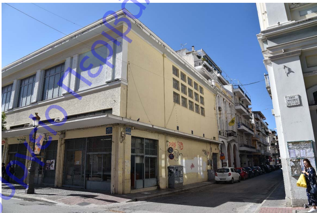
ΦΩΤ. 2: Όψη από οδούς Μαιζώνος - Βότση
