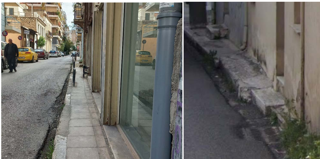
Εικόνα 31: Παραδείγματα ανεπαρκούς πλάτους (οδ. Μαιζώνος) & απουσίας πεζοδρομίου (Οδ. 12 ου Συντάγματος)
