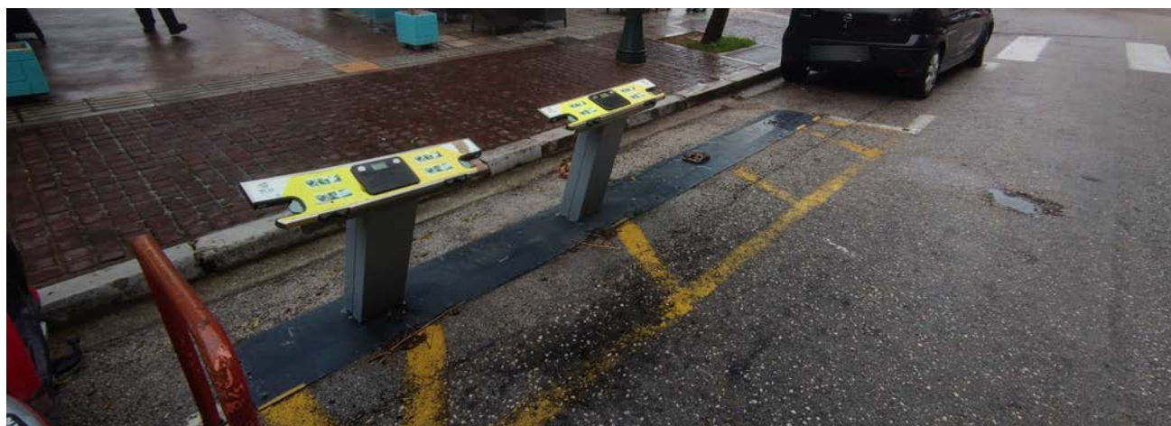
Εικόνα 62: Υποδομή συστήματος κοινόχρηστων ποδηλάτων (Πλατείας Υψηλά Αλώνια)
