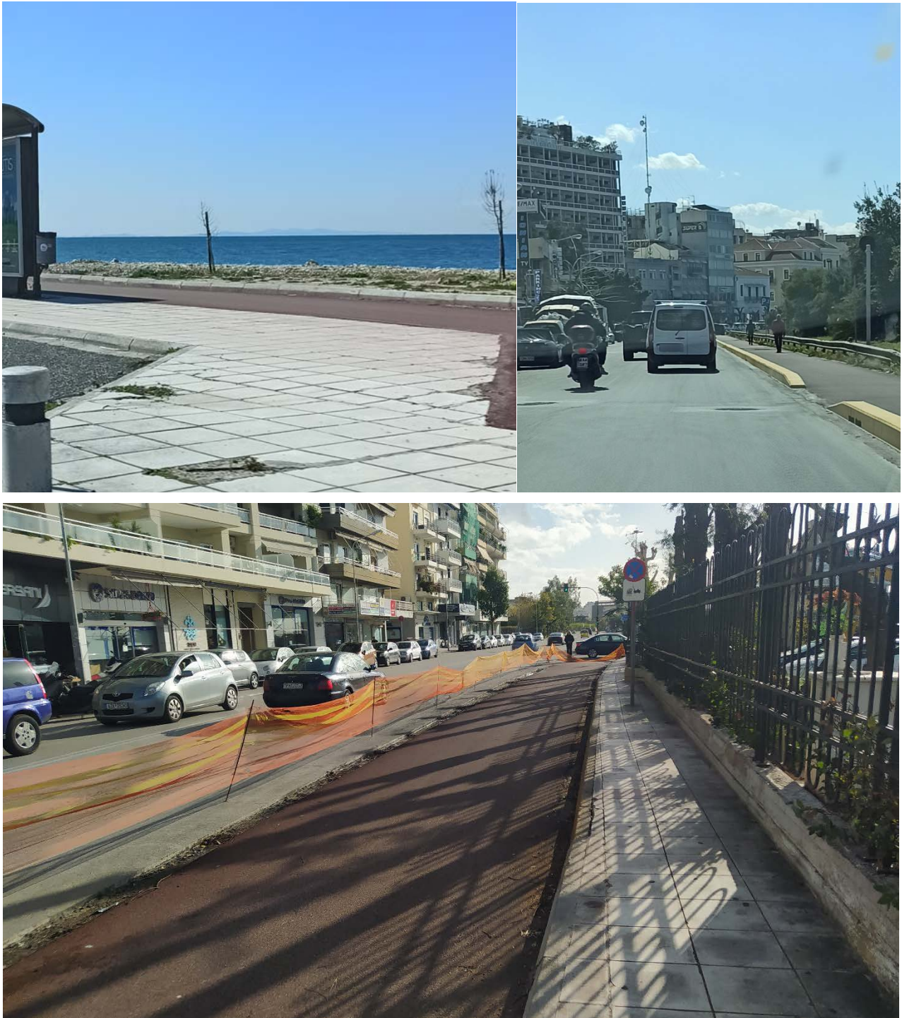
Εικόνα 59: Υπό κατασκευή παραλιακή διαδρομή ποδηλατοδρόμου (Κανελλοπούλου - Παπαφλέσσα)
