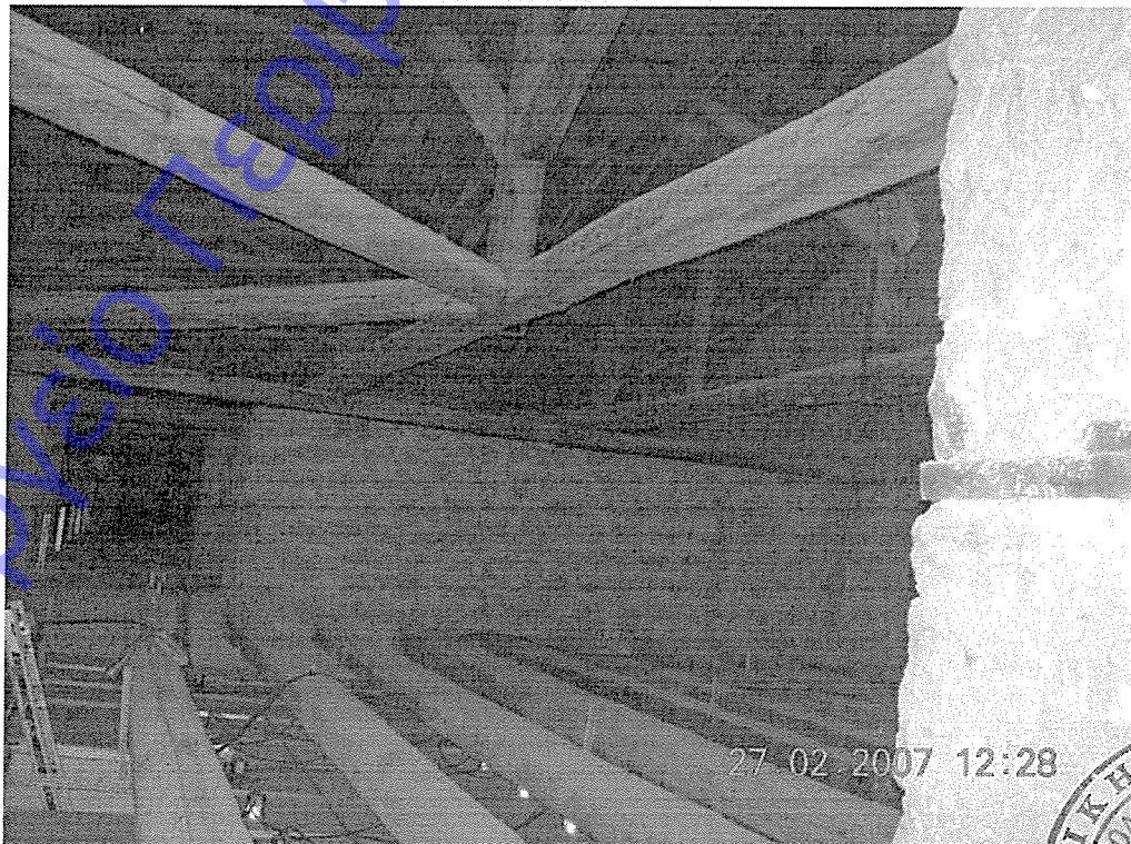
Φωτ. 7, Ξύλινο ζευκτό στέγης και οριζόντια δοκάρια
