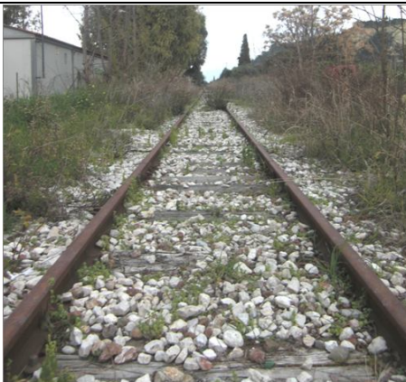
ΥΦΙΣΤΑΜΕΝΗ ΚΑΤΑΣΤΑΣΗ ΣΙΔΗΡΟΔΡΟΜΙΚΗΣ ΓΡΑΜΜΗΣ ΣΤΟΝ ΟΙΚΙΣΜΟ ΤΩΝ ΚΑΜΙΝΙΩΝ
