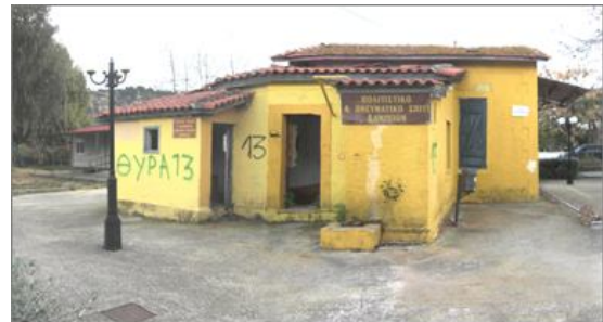
ΠΑΛΑΙΟΣ ΣΙΔΗΡΟΔΡΟΜΙΚΟΣ ΣΤΑΘΜΟΣ ΚΑΜΙΝΙΩΝ
