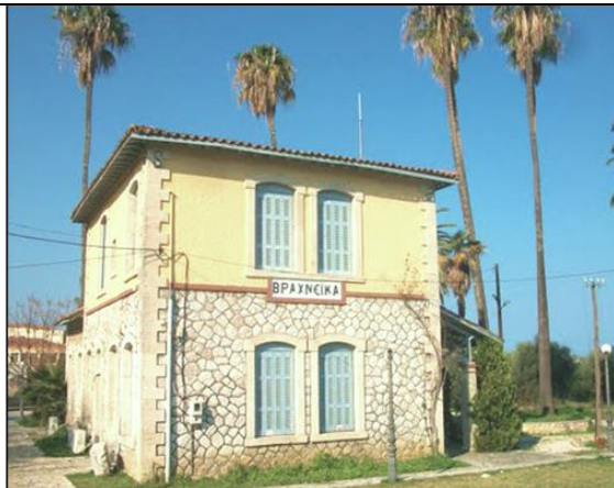
ΠΑΛΑΙΟΣ ΣΙΔΗΡΟΔΡΟΜΙΚΟΣ ΣΤΑΘΜΟΣ ΒΡΑΧΝΑΪΙΚΩΝ
